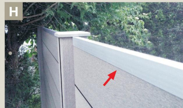
**H** Als obere Profilabdeckung wird ein Aluminium-Abschlussprofil aufgesteckt.
