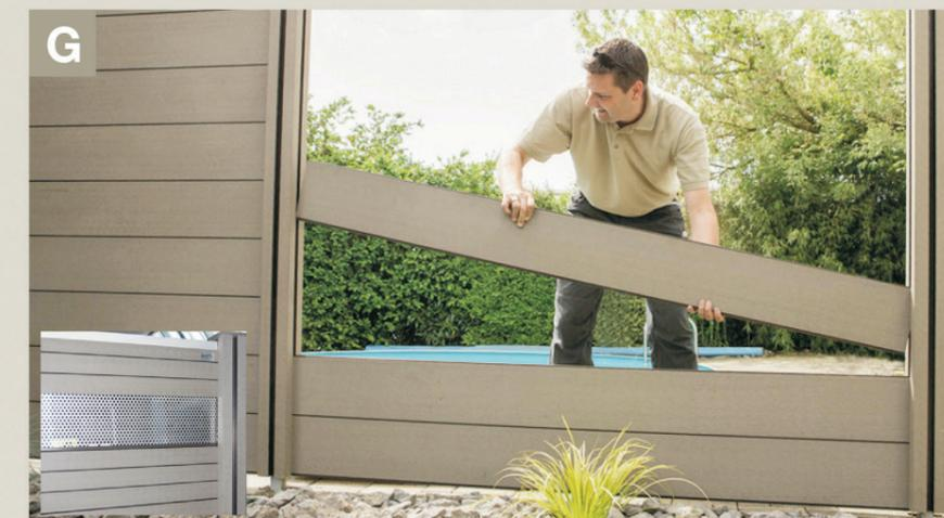
**G** Die weiteren Sichtschutzwand-Profile werden nacheinander von oben eingeschoben. Optional besteht die Möglichkeit, ein Sichtschutzwand-Profil durch ein Designelement (Glas oder Lochblech) zu ersetzen.
