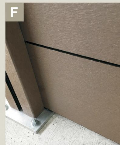
**F** Das erste Sichtschutzwand-Profil wird von oben zwischen den beiden Pfostennuten positioniert und nach unten bis auf die Pfostenplatte geschoben.
