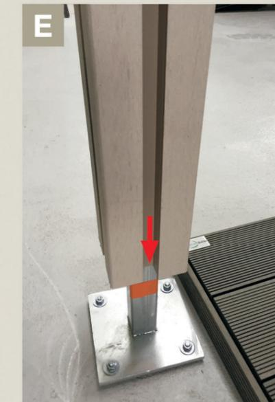
**E** Pfostenkonsole muss satt im Sichtschutzwand-Pfosten stecken.
