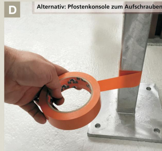
**D** Alternativ: Pfostenkonsole zum Aufschrauben
