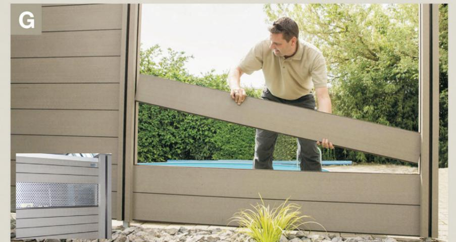
**G** Die weiteren Sichtschutzwand-Profile werden nacheinander von oben eingeschoben. Optional besteht die Möglichkeit, ein Sichtschutzwand-Profil durch ein Designelement (Glas oder Lochblech) zu ersetzen.
