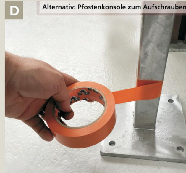
**D** Alternativ: Pfostenkonsole zum Aufschrauben
